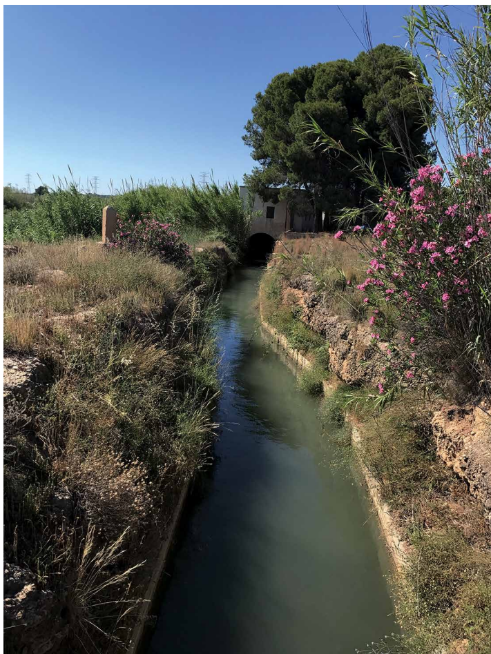
Azud de la Acequia de Mestalla. Detalle de la Casa Partidor
